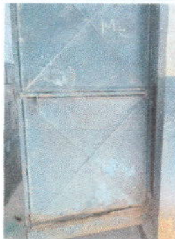
Foto 5: Fabricación e instalación de puertas de metal en módulos
