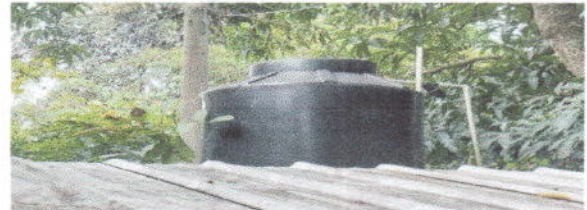
Foto 10: Sustitución de deposito de agua 2,500 lts
