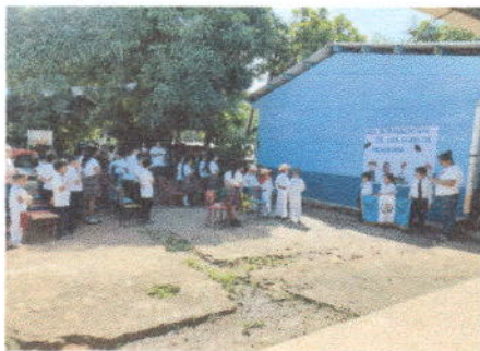
Foto 3: Reparación de piso torta de concreto
