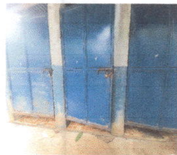
Foto 6: Fabricación e instalación de puertas de metal en baños
