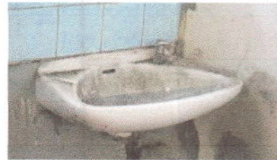
Foto: 2 sustitucion de lavamanos
