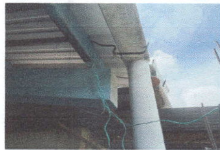
Foto 4: Sustitución de canal PVC
