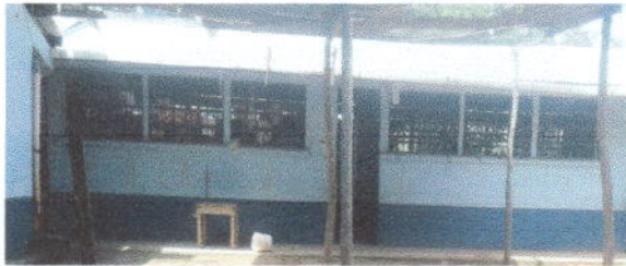
Foto 9: Pintura en muros exteriores e interiores
